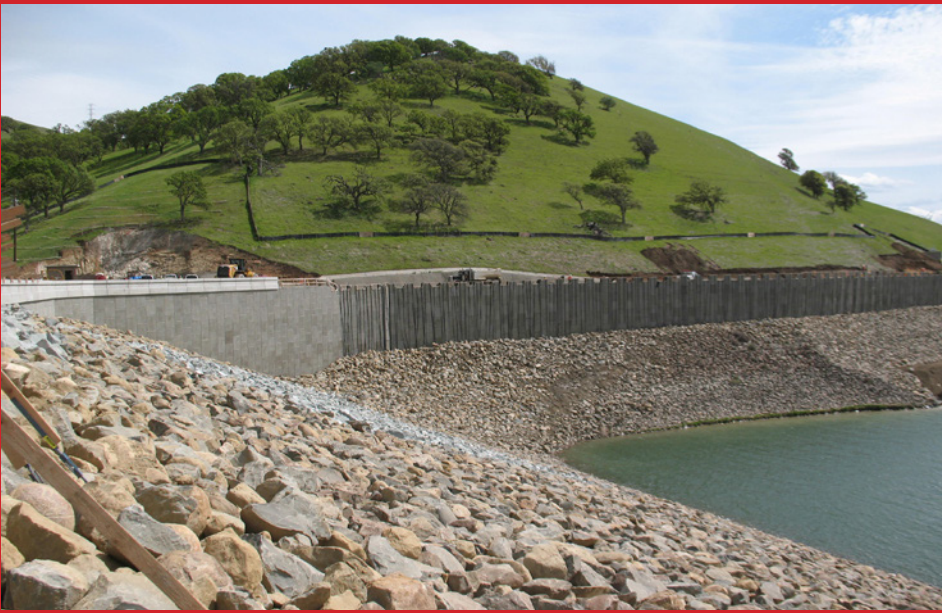
Los Vaqueros dam, California, USA
